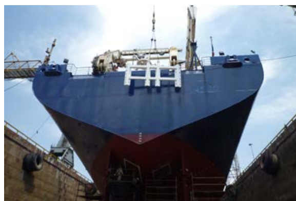
Installation de la nouvelle sismique sur le Marion Dufresne © Ifremer
